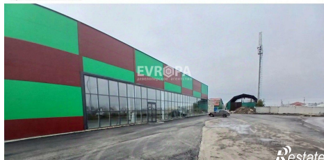
ФОТООБЗОР ФАСАДА Парковка на 50 машино-мест
